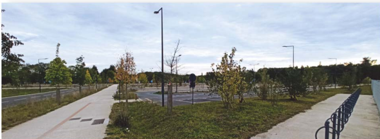
Parking des Montées – 100% GIEP - Zénith & CO 'Met - Orléans
