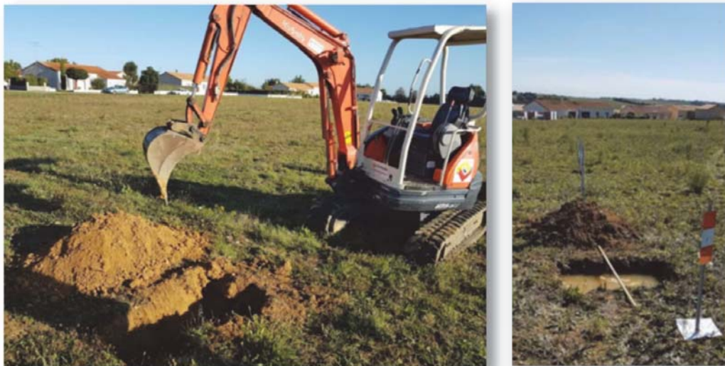
Source : Photographie de chantier - INFRA Services
