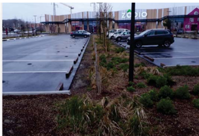
Source : Parc de stationnement en enrobé classique et noue – Cap Saran, Saran
