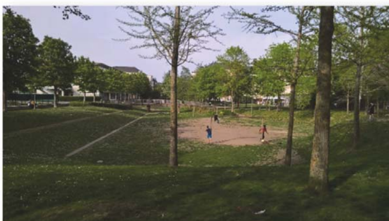
Aire de jeu inondable quartier Saint-Marceau, Orléans – Source : Photo Pôle DREAM
