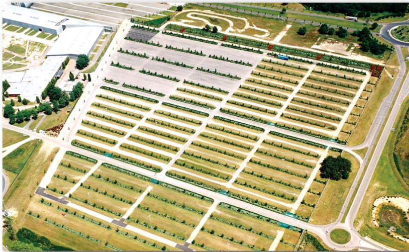
Source : Parking du Zénith de Rouen - INFRA Services
