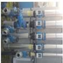
Équipements de maintenance.
