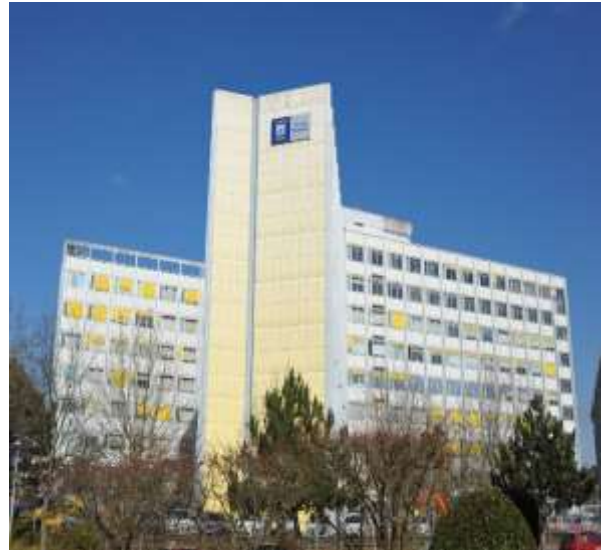
Bâti tertiaire Bâtiment de la poste à Orléans La Source
