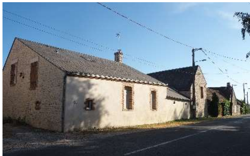
Bâti agricole Ferme « Longère » Les Epoisses à Boigny sur Bionne
