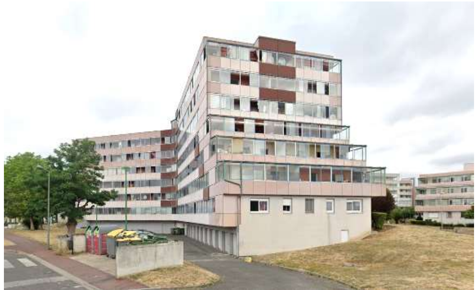
Bâti rue des Agates à Saint Jean de la Ruelle
