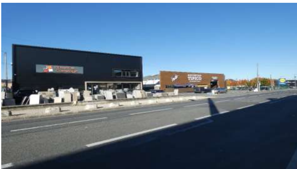
Type de locaux commerciaux en bordure de la RD 2020 face aux anciens bâtiments « Tobacco » Source Commission d'enquête
