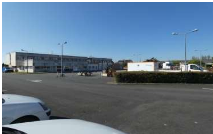
Vue générale du site ENEDIS - Source Commission d'enquête
