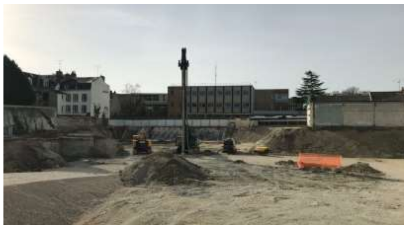
Ci-dessus travaux sur l'ancienne école de commerce
