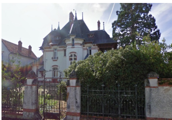
Clos des Moulins « villa Debienne » -
