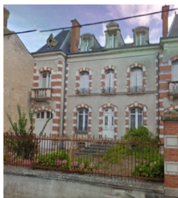
20 rue du Mal Leclerc
