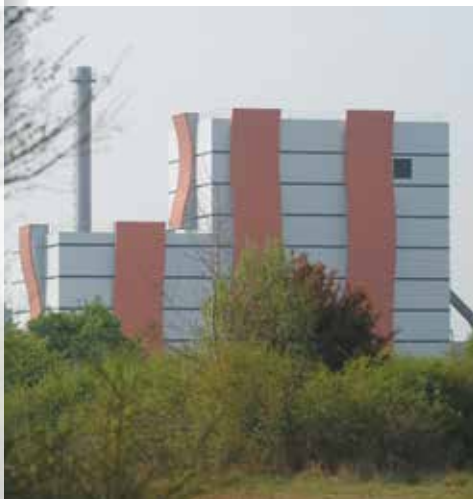
Chaufferie biomasse en construction au nord d'Orléans.
