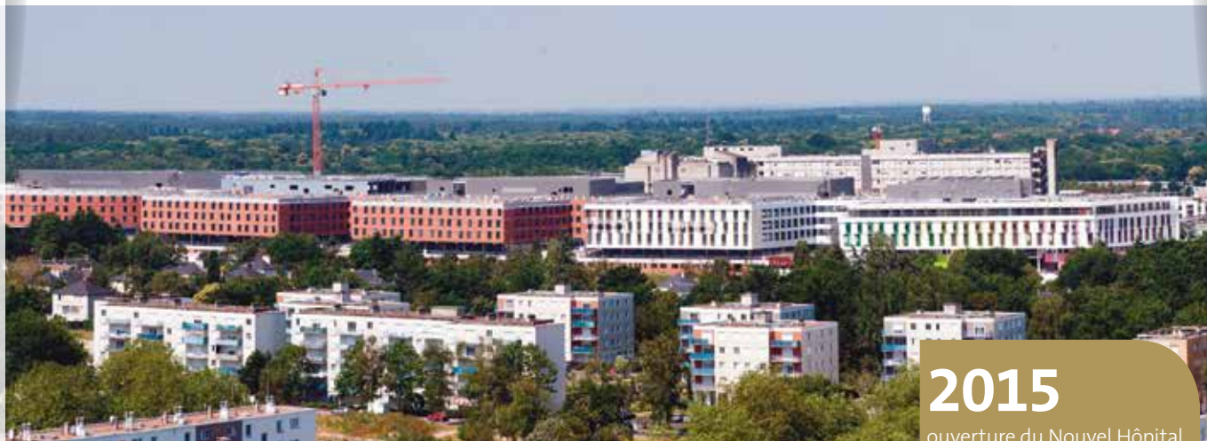
Le Nouvel Hôpital d'Orléans, en construction sur le site actuel du CHR, à La Source.
