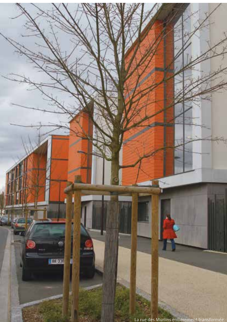
La rue des Murlins entièrement transformée.
