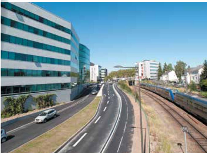
La Zac Coligny, en bordure de l'avenue de Paris (RD 2020).
