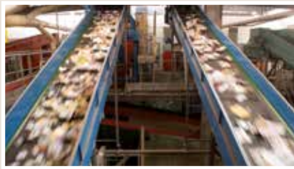
Centre de Tri des Collectes Sélectives (CTCS)
