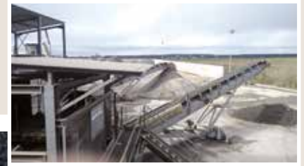
Installation de Maturation et d'Elaboration des mâchefers (IME)
